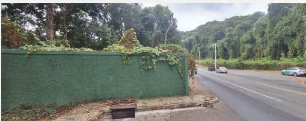
Falta de sinalização adequada e ausência de banheiro químico.
